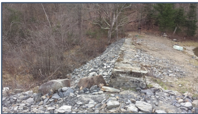
Vue sur l'enrochement et le barrage original David Brisson | 2017
