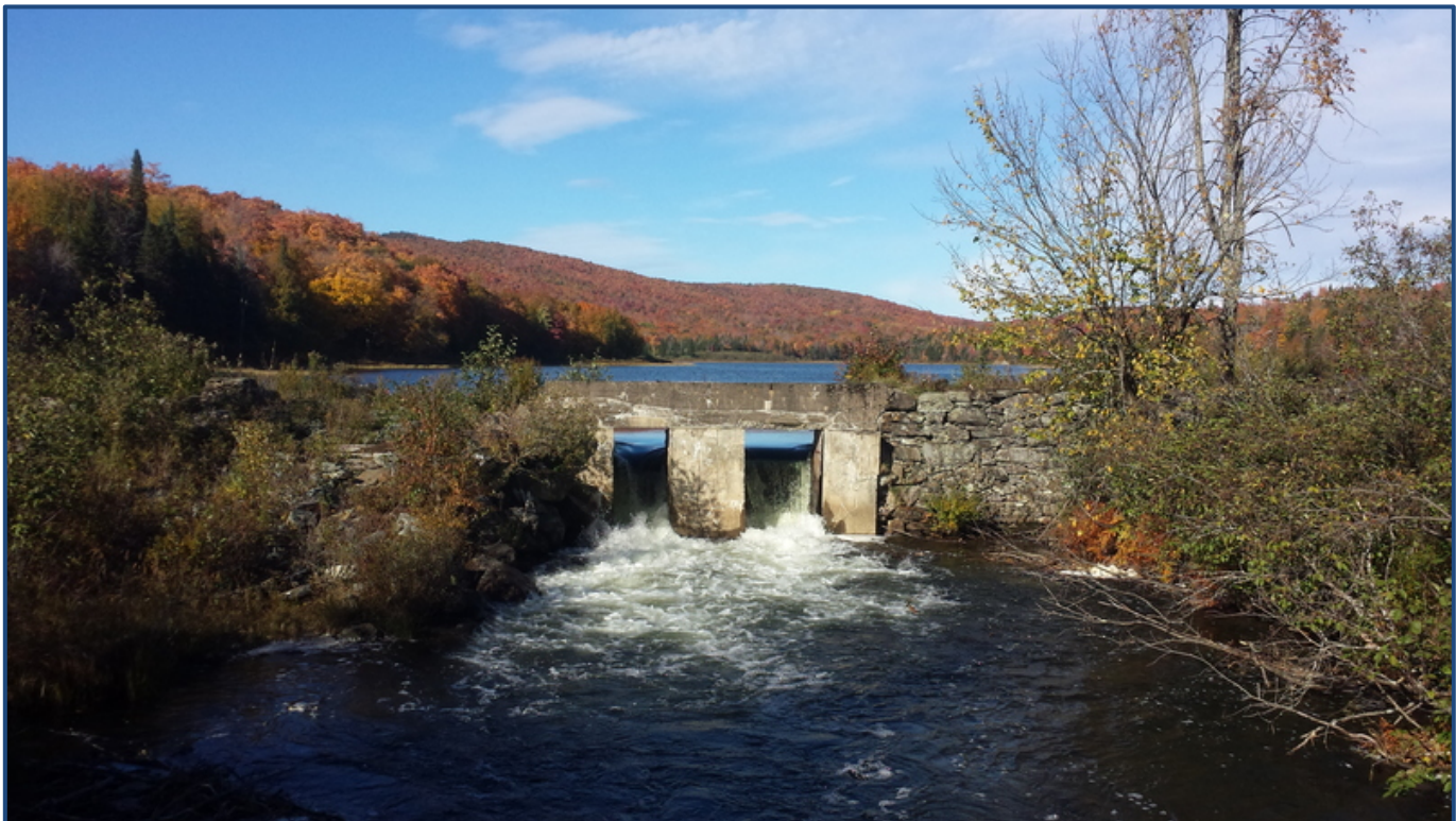
L'étang Fullerton et son barrage David Brisson | 2016
