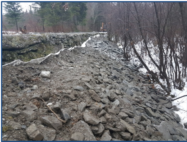
Enrochement en aval de l'étang Photo de David Brisson | 2017
