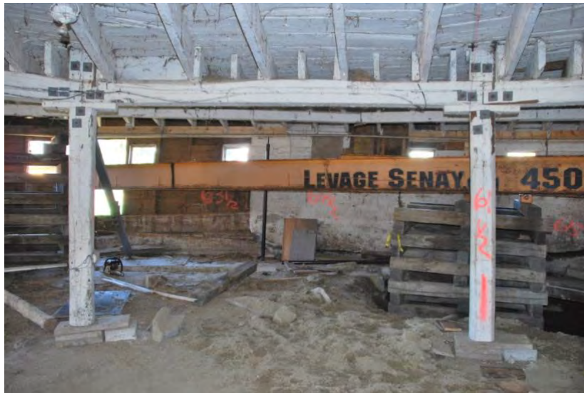
Soulèvement de la grange ronde pour mettre en place les nouvelles fondations
