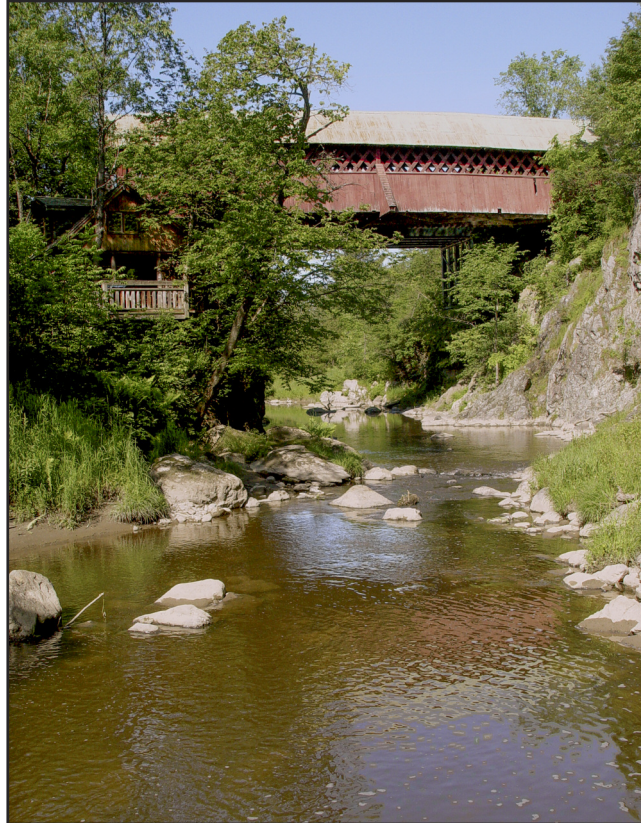
Pont de la Frontière de la Frontière Bridge (Niels Jensen)
