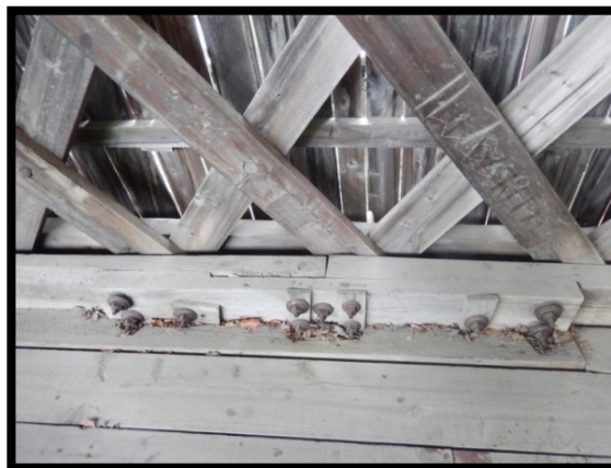
Photo no 10 – Ferme et moises Michael Grayson
