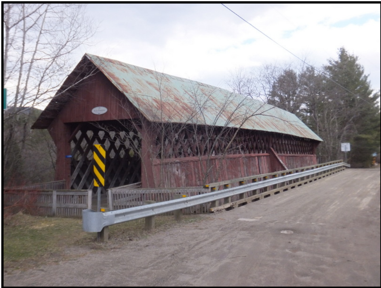
Le pont de la Frontière – The Pont de La Frontière
