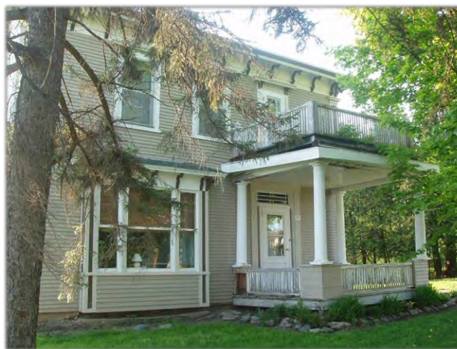
Maison patrimoniale au 283, rue Principale Heritage building, 283 rue Principale
