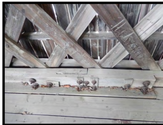
Photo no 10 – Ferme et moises Michael Grayson
