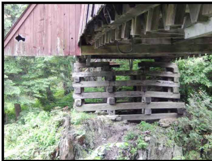
Photo no 8 – Culée sud du pont de la Frontière Michael Grayson
