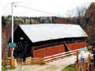
Mur contrefort et lambris à la verticale
