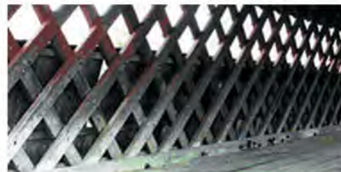
Poutres triangulées du type Town simple
