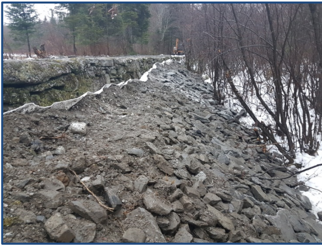
Enrochement en aval de l'étang Photo de David Brisson | 2017
